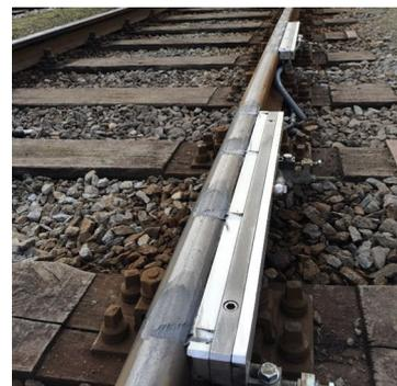
**Abbildung 2:** an der Schienenaußenseite montierte Leisten zur Aufbringung des Konditioniermittels am Schienenkopf.
